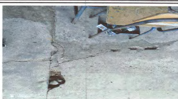
Foto 2: Sustrucción de torta de cemento por piso cerámico.
