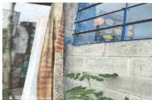
Foto 2: Sustrucción de canal.
