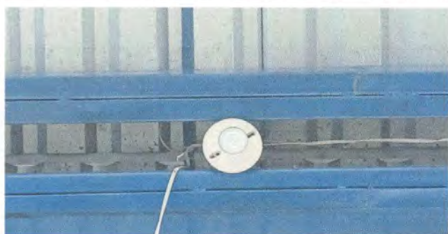
Foto 3: Sustrucción de plafoneras.
