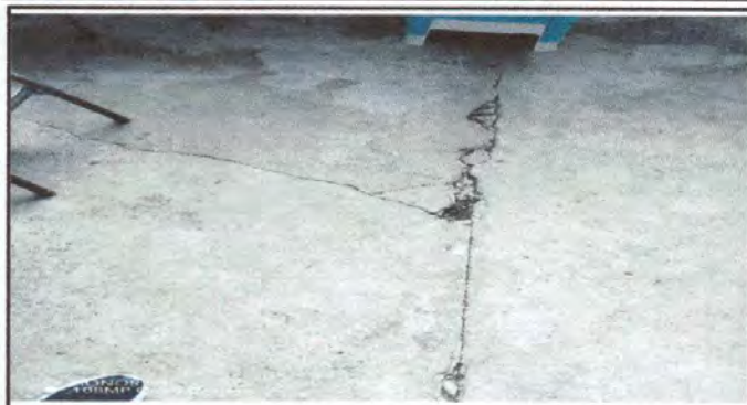
Foto1: Sustrucción de torta de cemento por piso cerámico.
